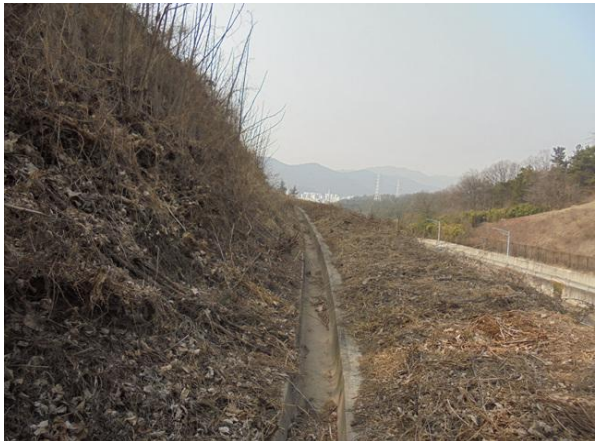
1소단 배수로 전경
