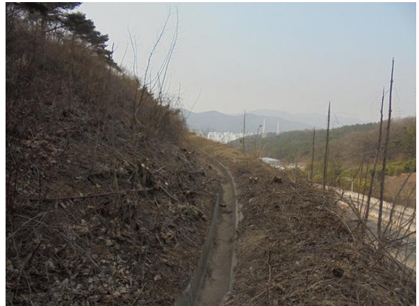
2소단 배수로 전경
