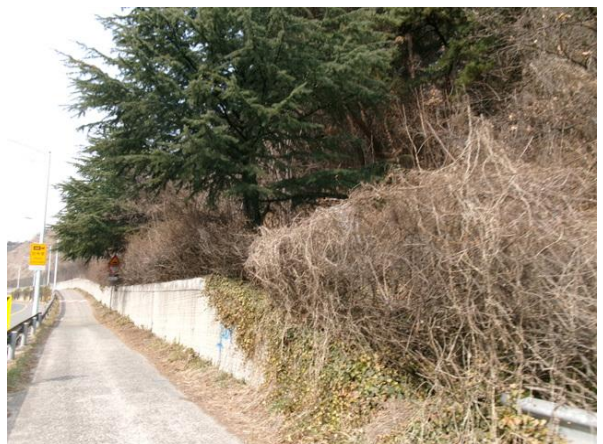
낙석방지울타리 및 하부 전경
